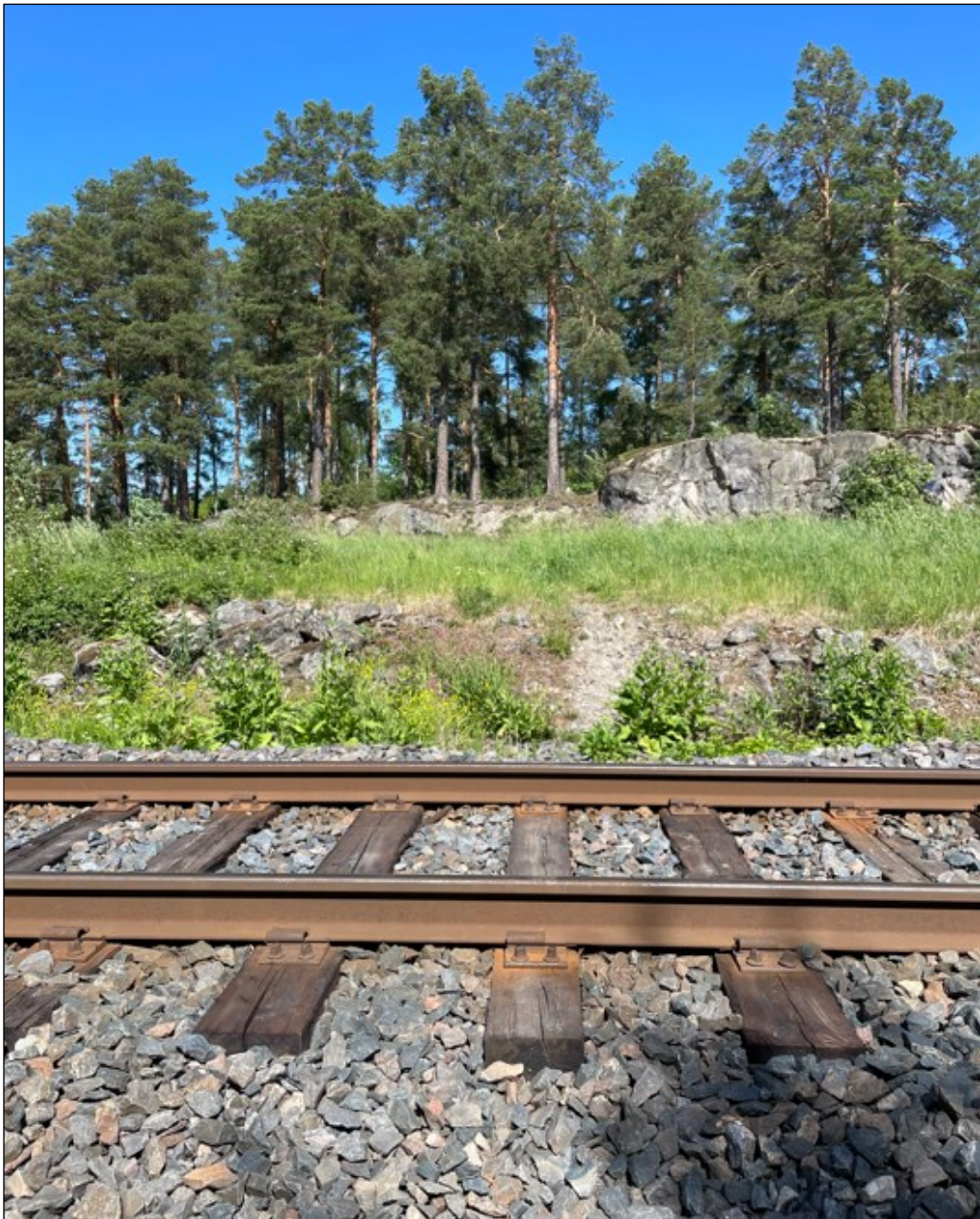
Kuva 6. Nykyinen radan päällysrakenne.
