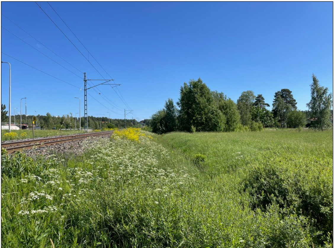
Kuva 10. Näkemä etelän suuntaan noin km:n 206+560 kohdalta. Uusi laiturijärjestelmä sijoittuu kuvan katsoja suuntaan nähden raiteen oikealle puolelle.
